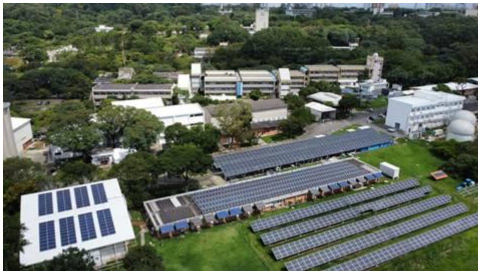
Figura 7: Sistemas solares fotovoltaicos instalados no Campus da USP - Butantã
